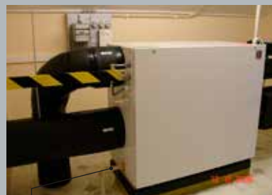
Vesilukko, korkeus on oltava tarpeeksi suuri (padotuskorkeus).
