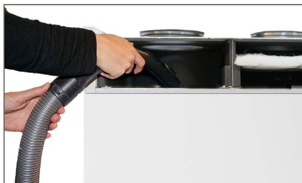
4. Suodatinkammiot on hyvä imuroida suodattimia vaihdettaessa.
