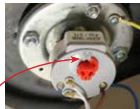
Lämpötilarajoittimen palautus
